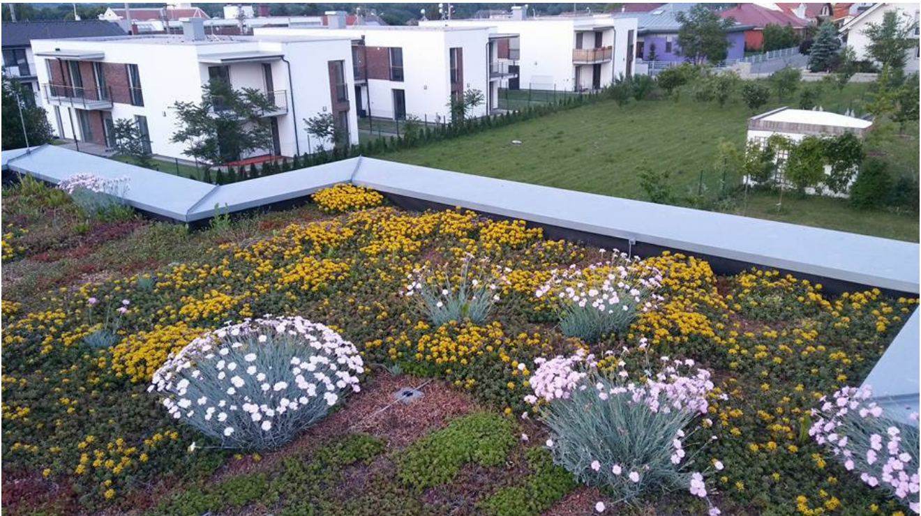
Extenzívna vegetačná strecha vysadená rozchodníkmi (Sedum) a trvankami. Autor: Zuzana Hudeková
