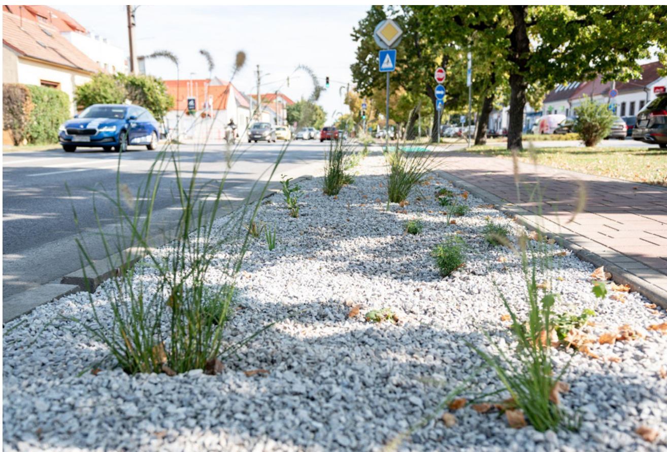
Vybudovaný vsakovací záhon. Autor foto: Mestská časť Vajnory
