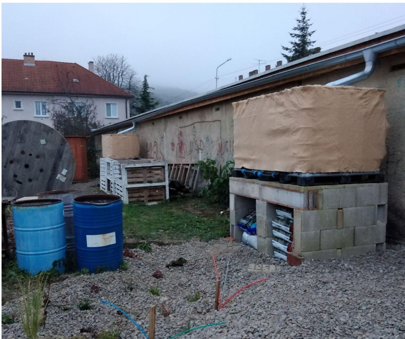
Priestor pod zbernými nádržami slúži zároveň na uskladanie materiálu, prebytočná voda zásobuje blízky dažďový záhon. Autor foto: OZ GaBa
