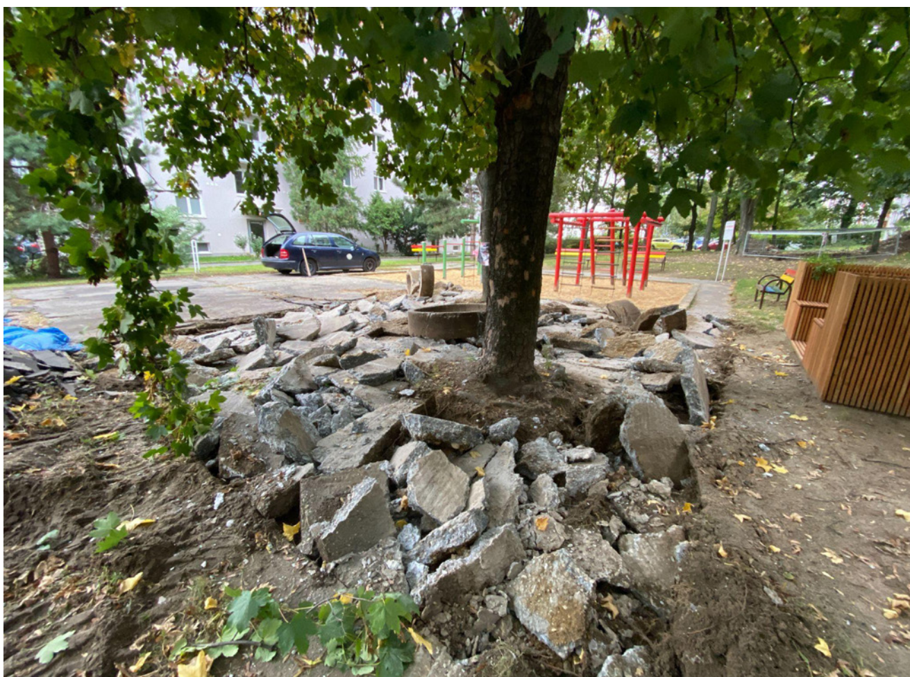
Odstránenie nepriepustných vrstiev z asfaltu a betónu. Autor foto: UrbanET Bratislava
